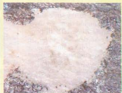
El láser IR pulsado es capaz de limpiar las capas de suciedad de la piedra sin dañarla.
